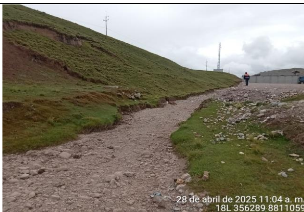
Fotografía 2: Quebrada huashanra, colmatado, erosion de riberas del cauce, sector Sacra Familia.
