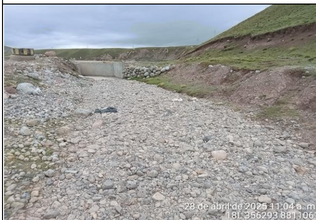
Fotografía 3: Quebrada huashanra, colmatado, erosion de riberas del cauce, sector Sacra Familia.
