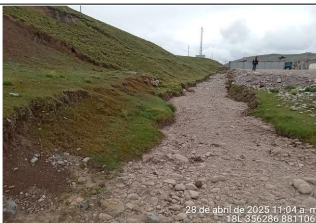
Fotografía 4: Quebrada huashanra, colmatado, erosion de riberas del cauce, sector Sacra Familia.
